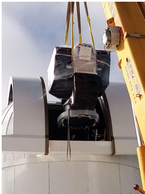
Монтаж на купола и на новия 1.5-м роботизиран телескоп.
