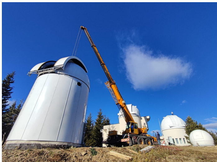
Монтаж на купола и на новия 1.5-м роботизиран телескоп.
